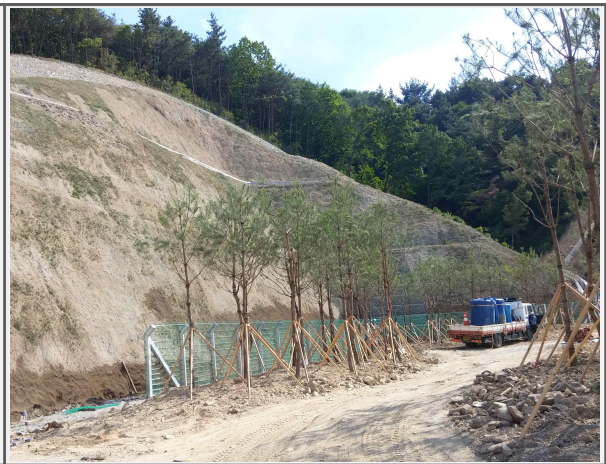
② 절토사면 시공 현황(중점 횡단)
