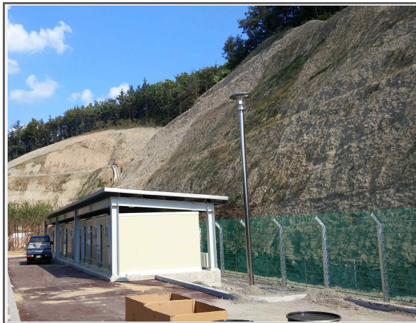
① 절토사면 시공 현황(시점 횡단)
